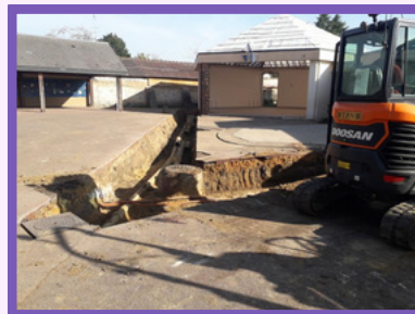
Remplacement des canalisations défectueuses
