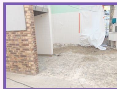
Dépose du sol en vue de la création de l'office de restauration, création d'une ventilation et de nouvelles lignes
