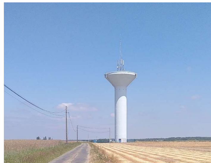
Château d'eau de la Chapelle-Réanville situé à l'extrémité Ouest de la commune (IEA)
