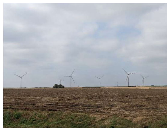
Parc éolien du village de Tourny
